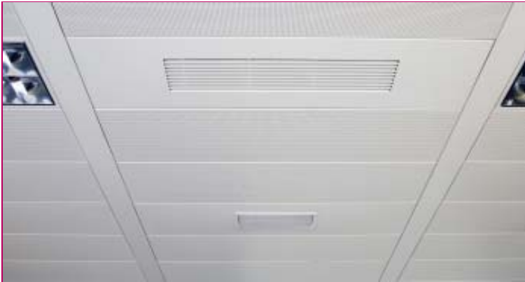
31-1 integrada en placa de falso techo
